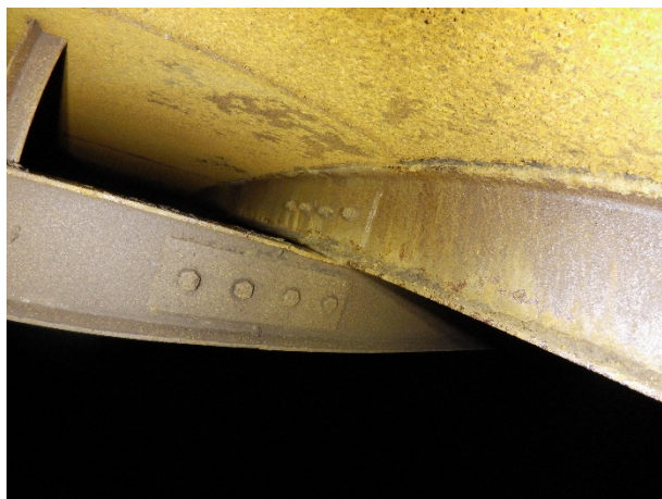
天井のボルト
