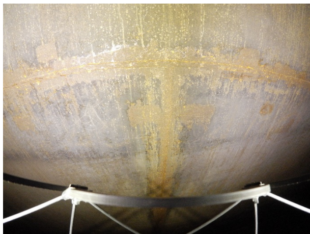
壁面の溶接線
